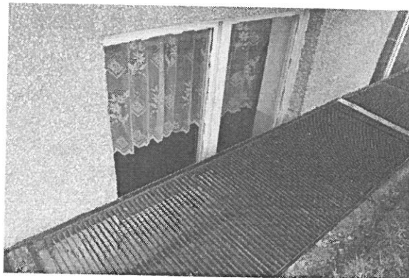
Okna -południowa strona szkoty-podziemie
