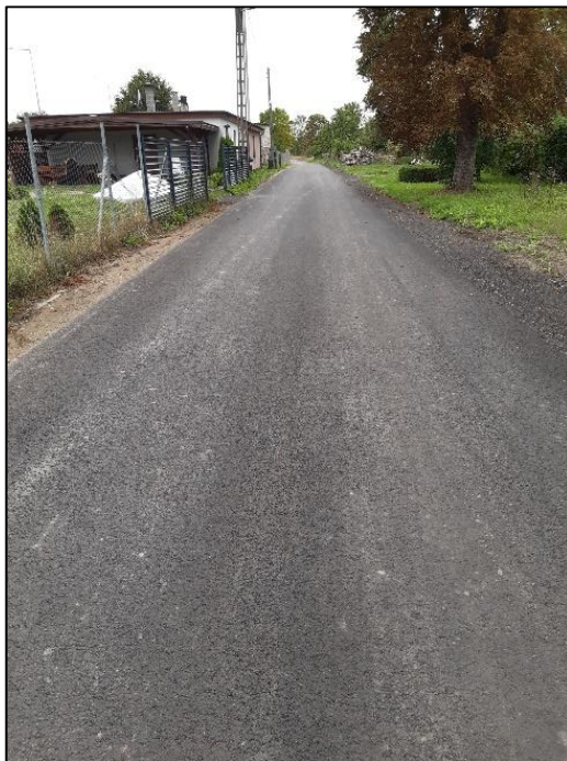
Droga w Tarnowie
