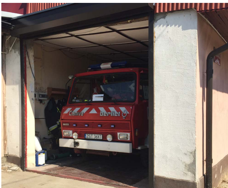
Fot.4. Widok elewacji z wymienioną bramą wjazdową
