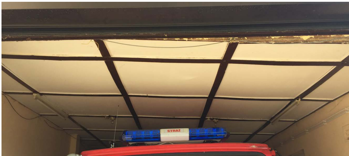
Fot.2. Widok nieocieplonego stropu
