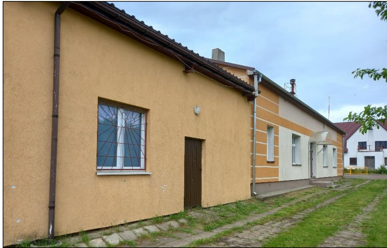
Obiekt garażu i świetlicy OSP w Brudzewicach
