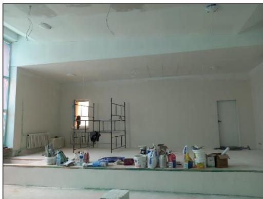
Prace remontowe w świetlicy
