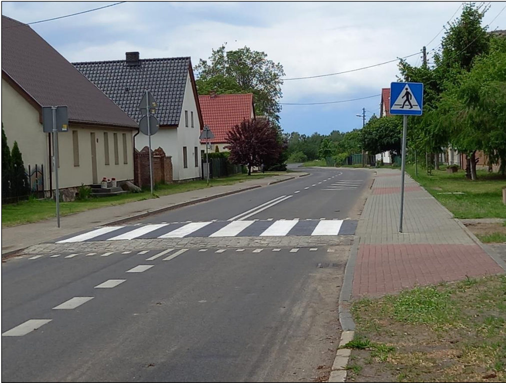
Droga w Brudzewicach
